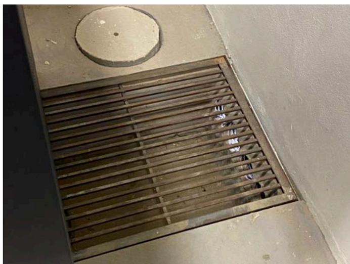
**Figura 7:** Ponto de entrada do cabeamento na subestação.
